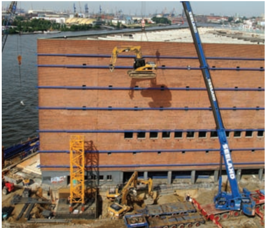
Vom Kaispeicher A zur Elbphilharmonie: Mit vier Baggern wurde das Gebäude im Hamburger Hafen Etage für Etage entkernt. Bis 2009 soll hier das neue Konzerthaus der Hansestadt entstehen – finanziert durch ein PPP-Projekt.
